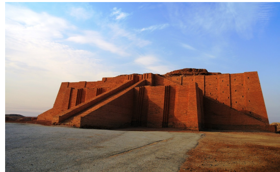
Zigurat de Ur, Irak. El Zigurat era un templo en la antigua Mesopotamia construido con ladrillos de adobe formado por diferentes niveles generalmente de forma rectangular. En la parte superior se encontraba el lugar de culto de distintos dioses y dioses y se ascendía a este a través de largas escalinatas. Imagen: Shutterstock
